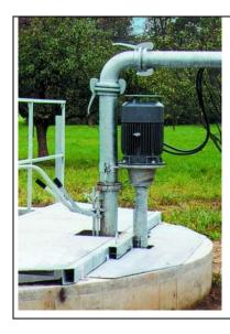
Насос устанавливается вертикально вплоть до основания ямы и крепится хомутом к поперечному держателю. Над ямой / емкостью крепится держатель и обязательно помост.
